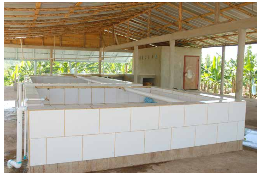
Planta para el lavado y curación del banano, para empacarlo.
